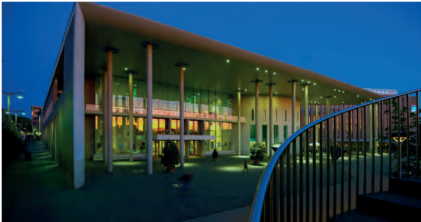
Locul de desfășurare a evenimentului – sala de concerte din Freiburg
